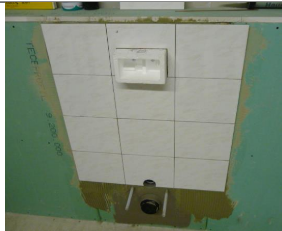
6b. Andre trinn av flismontasjen
