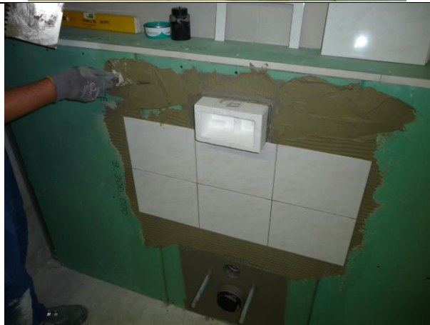
6a. Første trinn av flismontasjen
