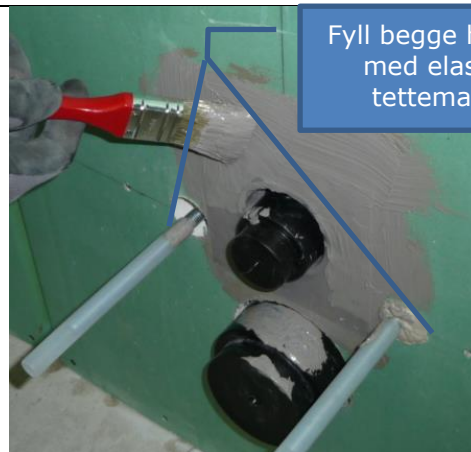
4c. Påfør lag 2 rett etter at flensen er strøket på plass.
