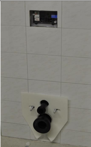
9. Etter at tettemassen har herdet, kan montasjen av porselent forberedes ved å sette støydempingen på plass.
