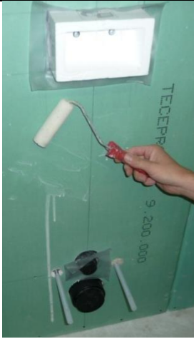
3. Påfør primer på frontplaten
