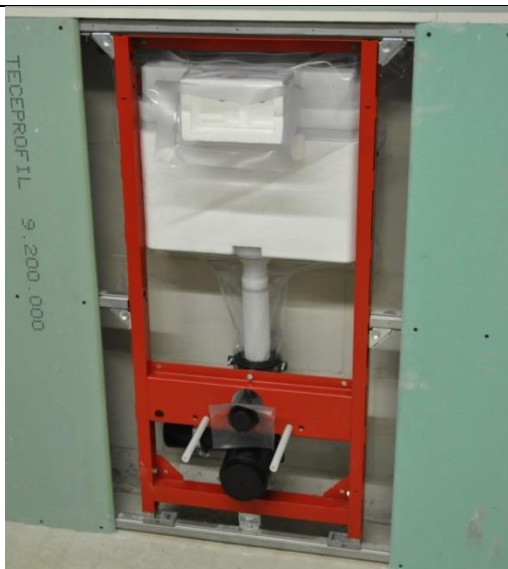
1. Installer WC-modulen i veggen.
