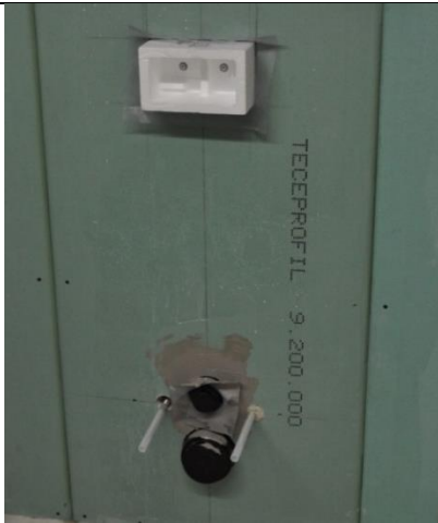
4. Påfør smøremembran på de aktuelle stedene.
