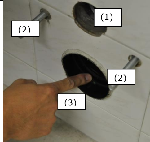
8d. Til slutt jevnes tettemassen ut ved alle fugene (1),(2),(3)
